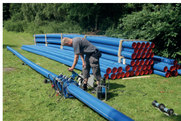
Vi udskifter løbende gamle og udtjente vandledninger med nye, moderne ledninger
