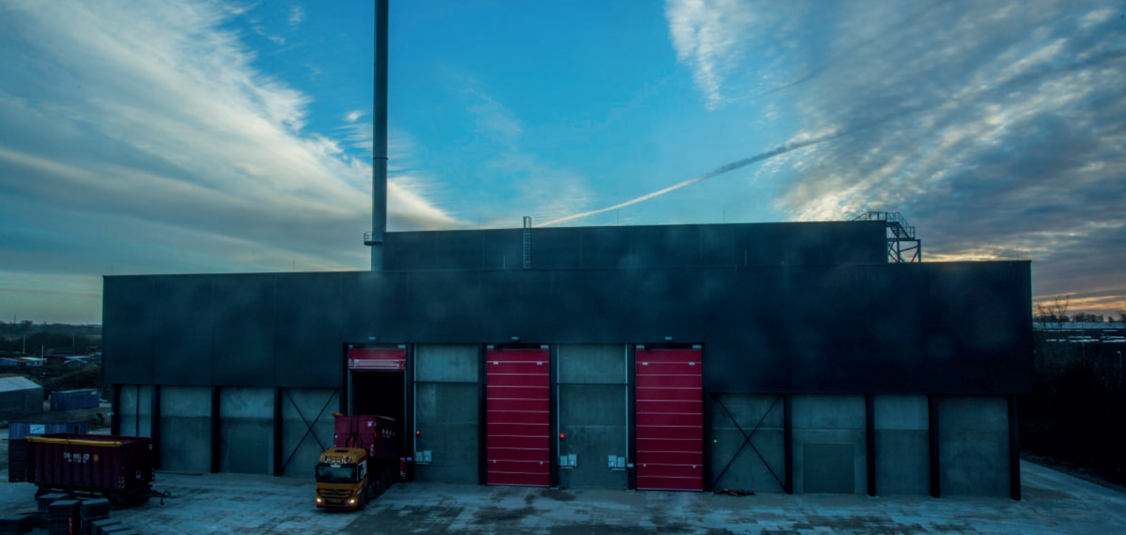
Hillerøds biomassefyrede kraftvarmeværk i smuk aftenbelysning
