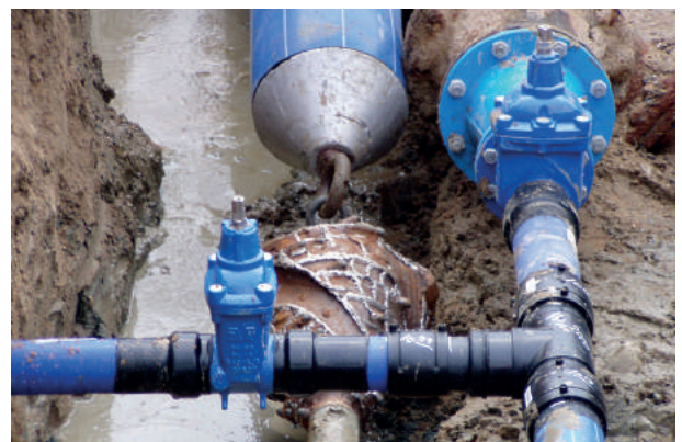
Vandledninger udskiftes med en styret underboring – en metode, der mindsker opgravning
