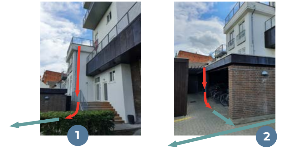
Regnvand fra tagnedløb 1 og 2 ledes via fodbøjninger til et mindre system af render og herfra videre til regnbedet på kanten af det grønne areal
