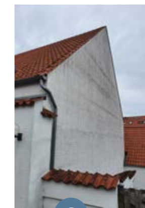
Tagnedløb 8 og 9 afvander i dag til baggårdens kloaksystem, men tagfladerne tilhører tilstødende nabobygningen. Tagfladerne der her er markeret med rødt afvander henholdsvis 170 m 2 og 40 m 2 .
