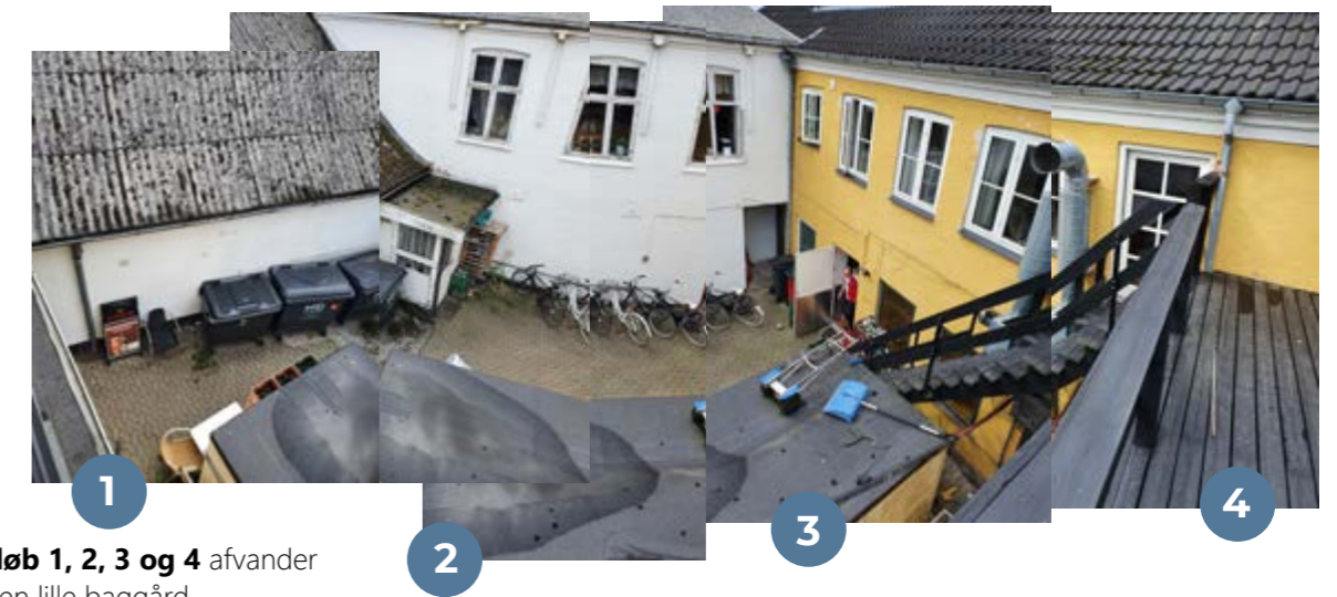
Tagnedløb 4 afvander tagfladerne på baggårdens vestlige bygning. Her kobler tagnedløb 5 , der afvander en mindre kvist, sig på. Tilsammen afvander de et areal på ca. 125 m 2 .
