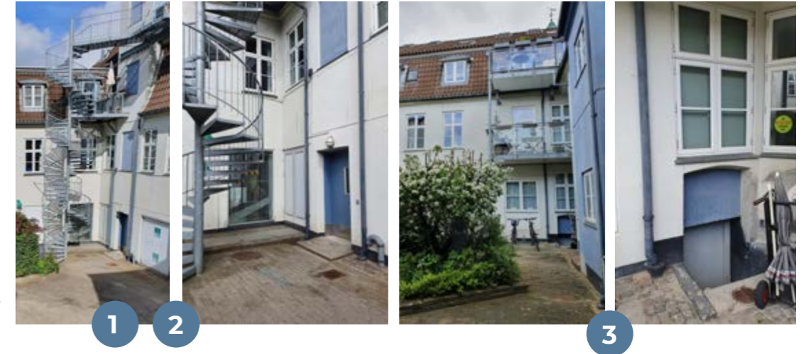
Tagnedløb 4 og 5 afvander baggårdens østlige tagflader. Tagnedløb 5 slutter i dag i et nedsænket areal. Samlet tagfladeareal vil være på ca. 65 m 2 og vandet herfra kan løbe i en åben rende, evt. til plantebed.
