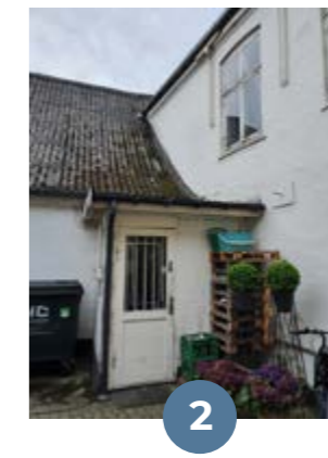
Tagnedløb 2 afvander det lille tag over indgangspartiet, et areal på ca. 2 m 2 .
